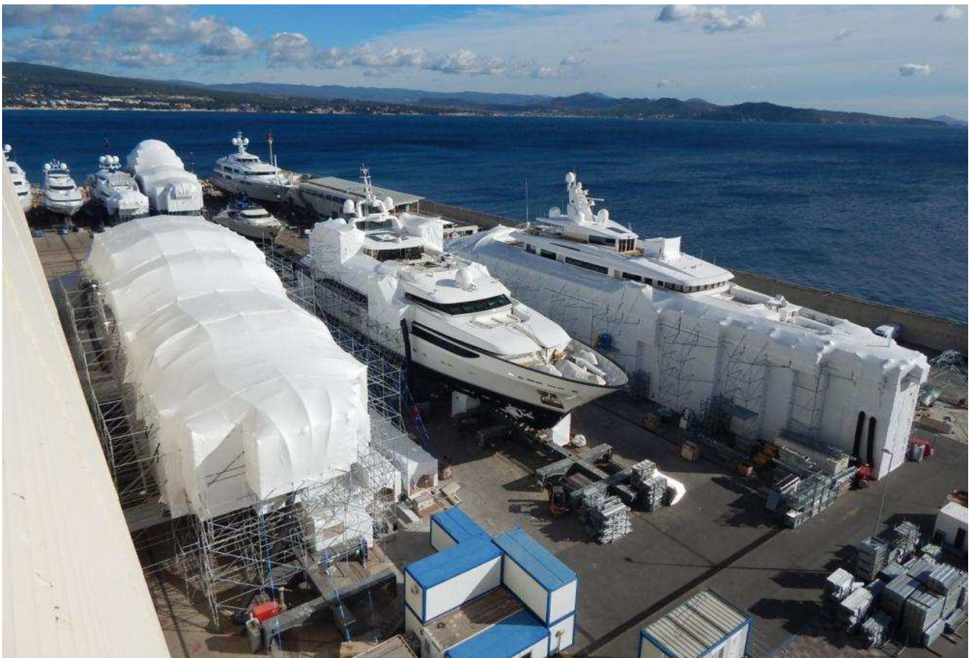
LE CHANTIER DE REPARATION MONACO MARINE A LA CIOTAT EN 2016 © MONACO MARINE
