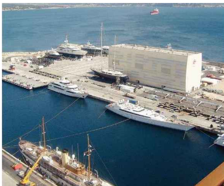
La première plateforme, lancée au début des années 2000, avait été financée par l'entreprise Monaco Marine, les collectivités et l'Etat. PHOTOS F
