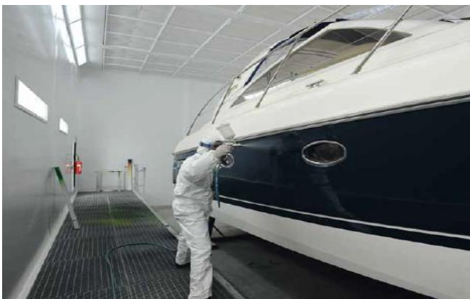
Cabine peinture ventilée
