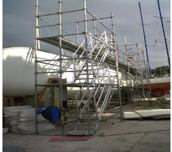
Echafaudage avec escalier pour travail et accès en hauteur
