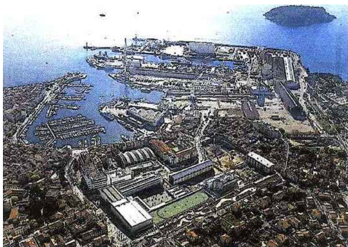
Les chantiers de La Ciotat veulent se doter d'un ascenseur à grands yachts, pour un marché également convoité par Marseille.
